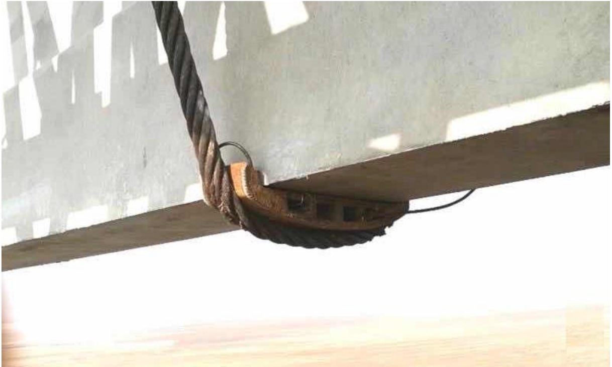
梁体底面转角与吊梁钢丝绳接触处设置钢瓦
